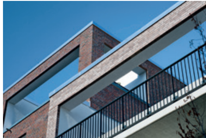
■ Im Bereich der Dachterrassen kamen vorgefertigte Stürze zum Einsatz, die auf der Baustelle lediglich auf das seitliche Mauerwerk aufgelegt und anschließend mit Konsolankern am Stahlbeton befestigt wurden.
